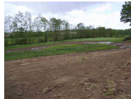
Décapage d'une zone humide
